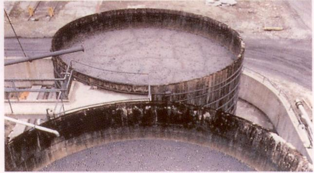
Couverture flottante de boules sur une installation de pâte à papier
